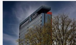
Renovatie EWI hoogbouw →
